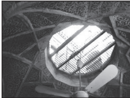
لوح (١١): النافذة المضلعة الواقعة في وسط قبة غرفة الحركة - مدرسة اليزدي
